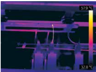
Überhitzter Starkstromtransformator
